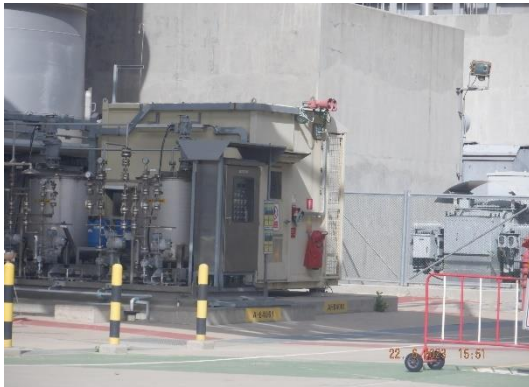
รูปที่ 2-1 การติดตั้งระบบตรวจวัดอากาศเสียแบบต่อเนื่อง (CEMS) ที่ปล่องระบายอากาศของ HRSG
